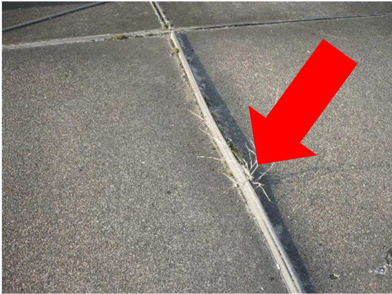
平面部伸縮目地の飛び出し
