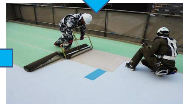
④オールコートとフラットA貼付け
