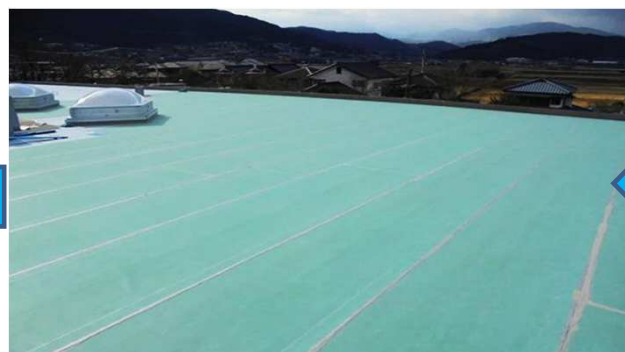
⑤フラットA施工完了
