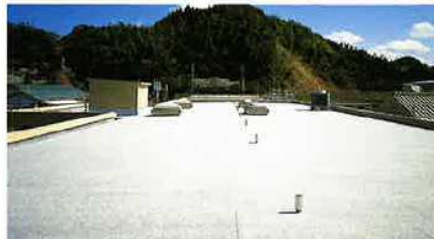
アスファルト防水露出砂付き仕上げ
