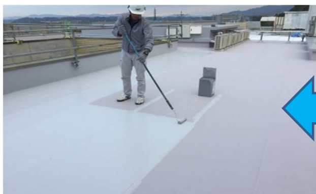
⑥保護塗料塗布(2回塗り)
