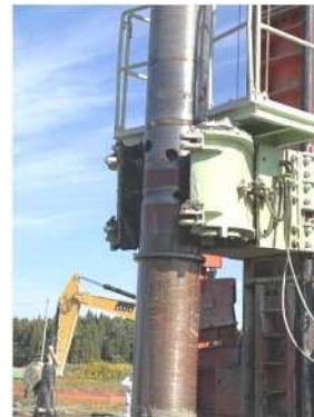
⑬翼付きケーシングのリブが通過する際は、振れ止めを開放する。
