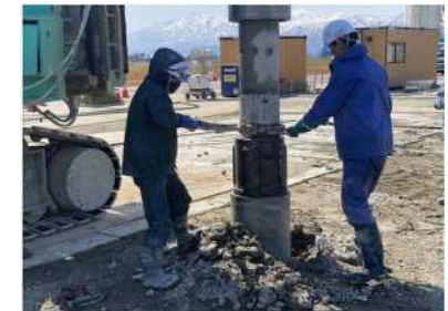
④ロッド用カンザシを外してケーシングを接続する。
