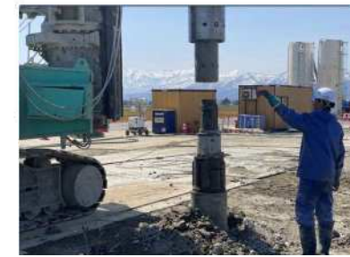
③埋め込んである継ぎ足し用ケーシングへ移動する。
