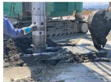
①所定の深度まで掘削後、カンザシを挿入する。
