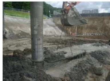
⑫オーガと翼付きケーシングを接続し、カンザシを抜く。
